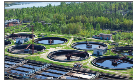
Trattamento delle acque reflue
